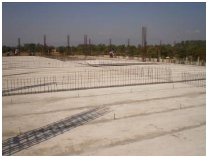
รูปที่ 17 แสดงการยาร่อง Shear key ในระบบพื้นคอนกรีต Hollow Core
