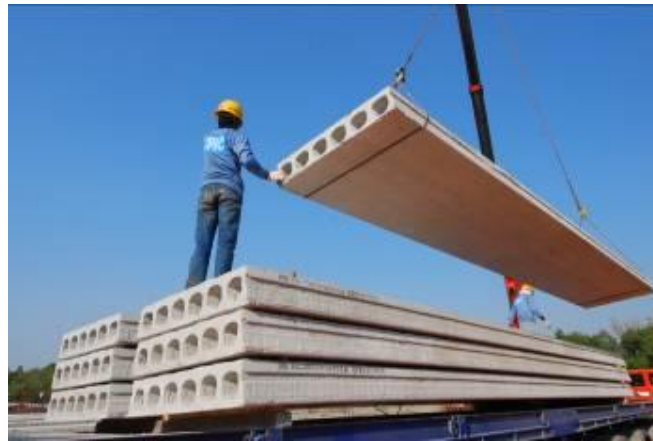
รูปที่ 9 แสดงการคล้องสลิงเพื่อยกแผ่นพื้นคอนกรีตอัดแรงชนิดกลวง
