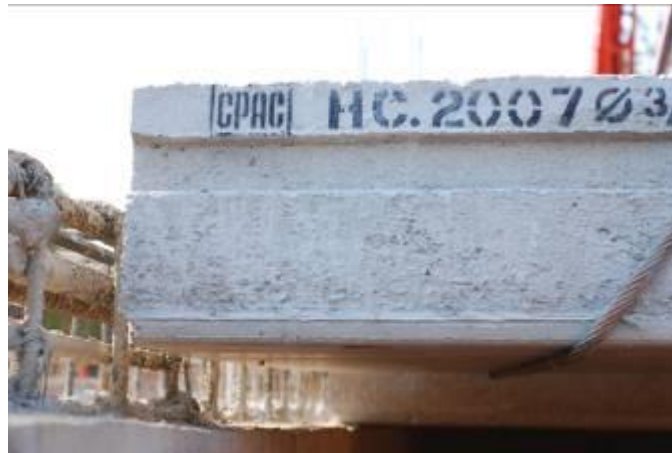
รูปที่ 14 แสดงการวางแผ่นพื้นคอนกรีตสำเร็จรูป Hollow Core บนหลังคาน
