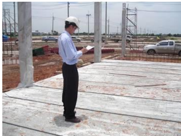
รูปที่ 15 พนักงานทำการตรวจงานติดตั้ง
