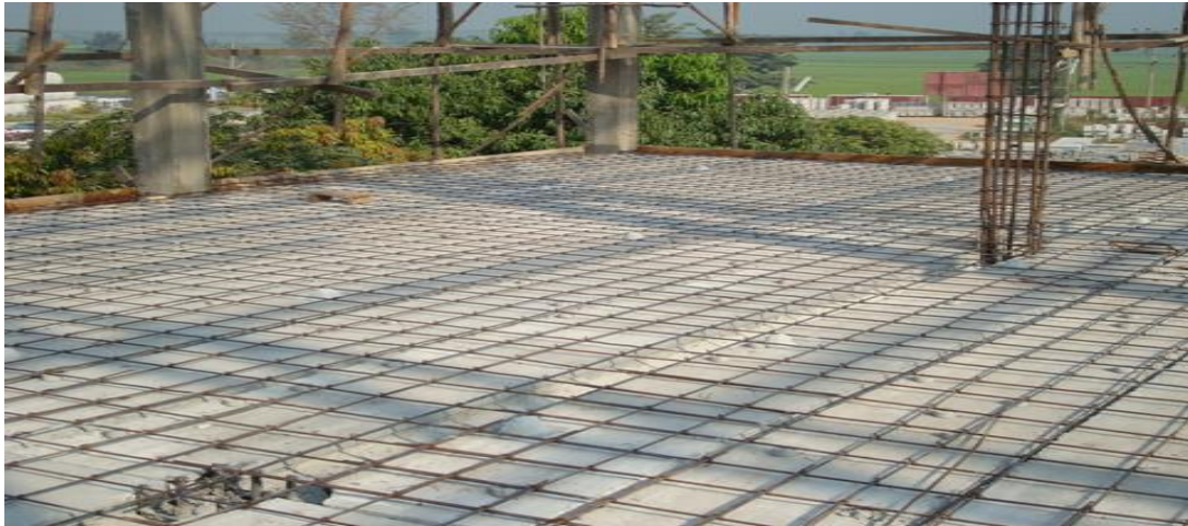
รูปที่ 18 แสดงการวางเหล็กเสริมตะแกรงป้องกันการแตกร้าว
