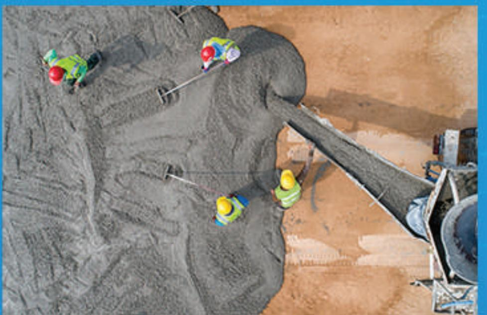
คอนกรีตที่ใช้สำหรับงานโครงสร้างทั่วไป ถูกออกแบบให้มีกำลังอัดตึงแต่ 180-400 ก.ก. / ตร.ซม. เหมาะสมสำหรับการนำไปใช้ในโครงสร้างทั่วไป เช่น เสา คาน ฐานราก พื้น เป็นต้น
