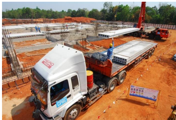
รูปที่ 8 รูปแสดงตำแหน่งของรถขนส่งที่เหมาะสมกับการใช้เครน
