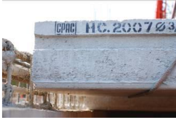
รูปที่ 14 แสดงการวางแผ่นพื้นคอนกรีตสำเร็จรูป Hollow Core บนหลังคา
