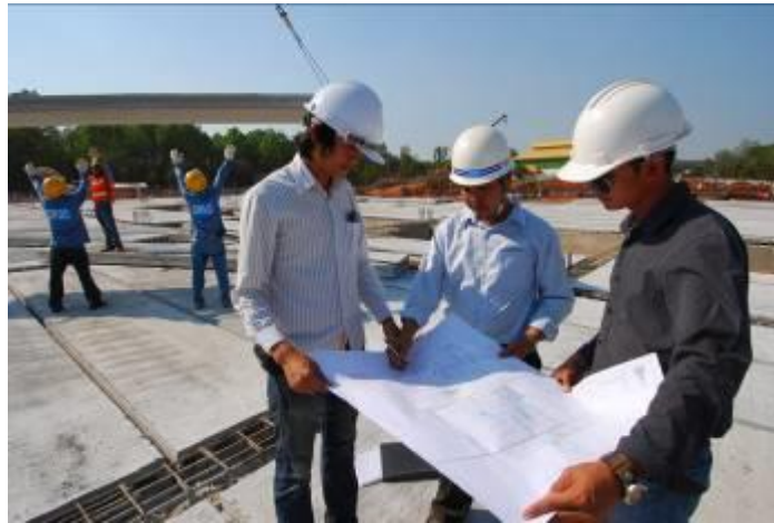
รูปที่ 12 แสดงการตรวจ Shop drawing ก่อนทำการติดตั้ง
