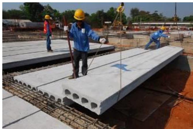
รูปที่ 13 แสดงการวางแผ่นพื้นคอนกรีตสำเร็จรูป
