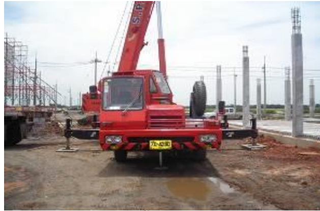
รูปที่ 7 รถเครนที่ติดตั้งบริเวณหน่วยงานก่อสร้าง
