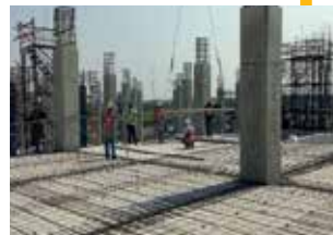
วางตะแกรงเหล็ก
