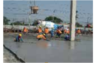
เทคอนกรีตทับหน้า
