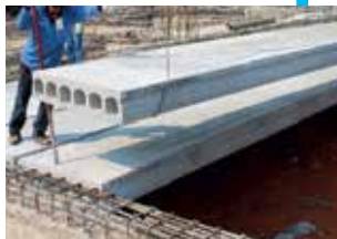
ยกแผ่นพื้นวางบนหลังคาน
